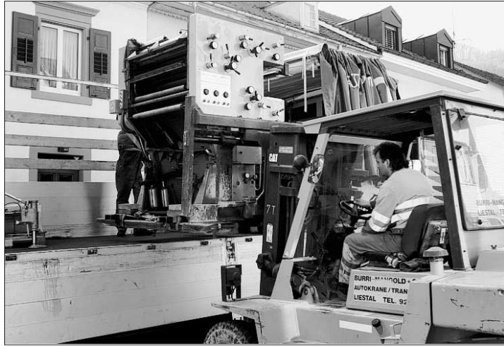
...das neue – rund sechs Tonnen schwere – Werk wird abgeladen...
